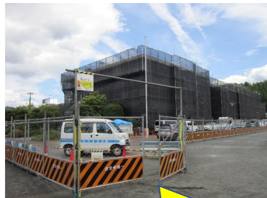
校庭側から見た様子
